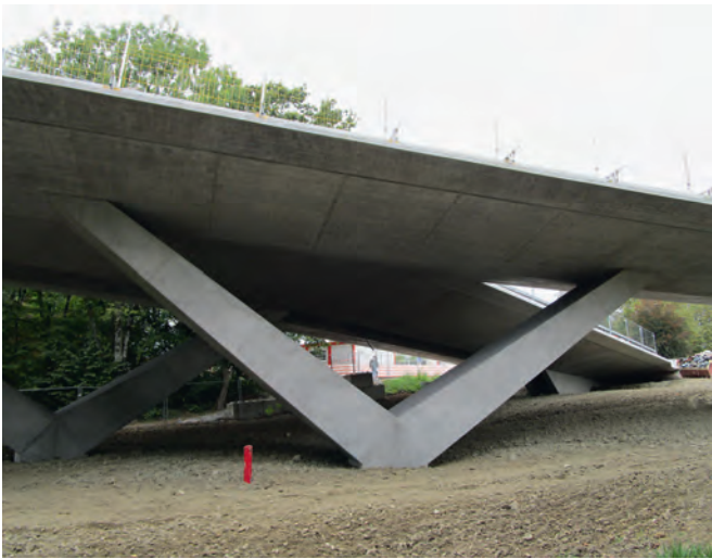
Fig. 4 Pile à béquilles en V. V-support pile.
