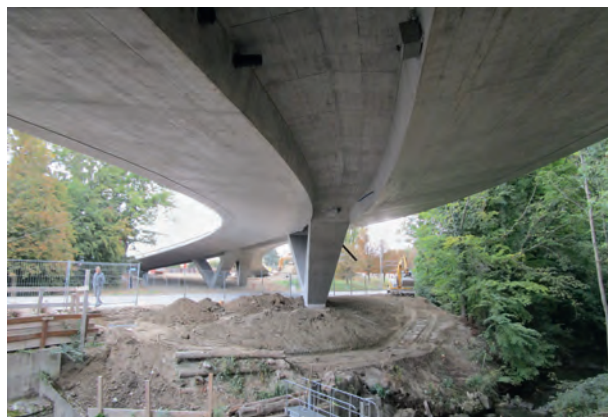
Fig. 3 Franchissement de la rivière de la Sorge et rainure centrale. Crossing of the Sorge river and central groove.
