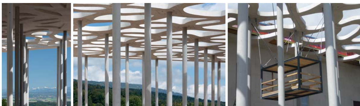
Fig. 2 Photos de la canopée avec ses colonnes préfabriquées. Photos of the canopy of the MdE with its slender precast columns.
