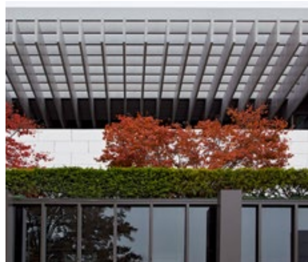
Neue Überdachung auf der bestehenden Terrasse im 2. OG.
