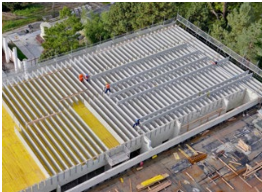
Links: Versetzen der Längsrippen auf der Baustelle. Rechts: Die Nocken auf der Stirnseite der Rippen vereinfachen die Fügung.
