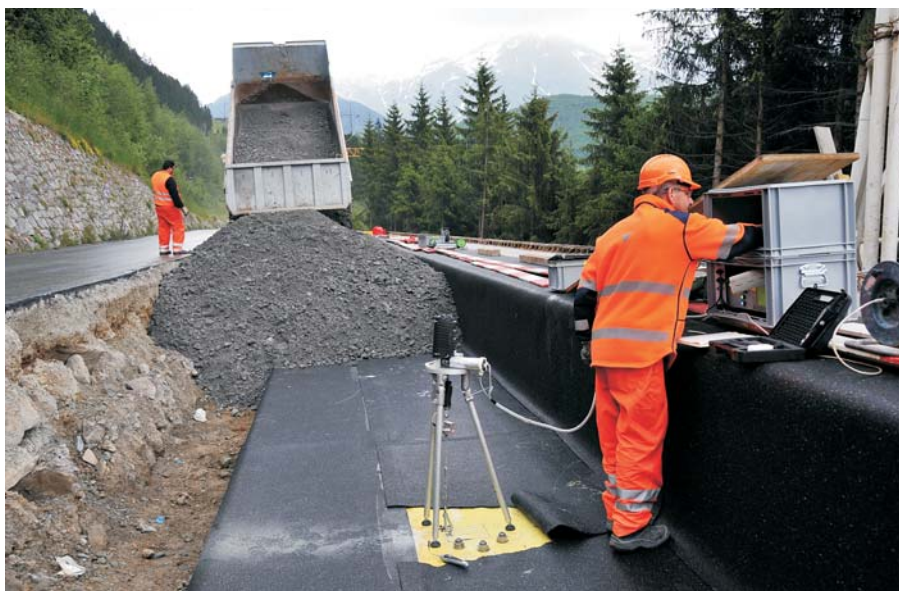
Qualitätsprüfung der Abdichtung und Einbringen des Strassenkoffers. Examen da qualitat da la stuppadira e da la consolidaziun dal letg da la via.
