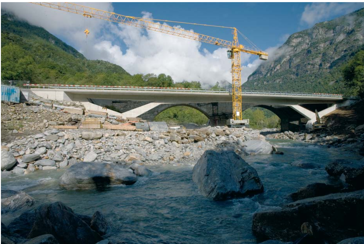
Fig. 1 Il nuovo ponte visto da valle. View of the new bridge.
