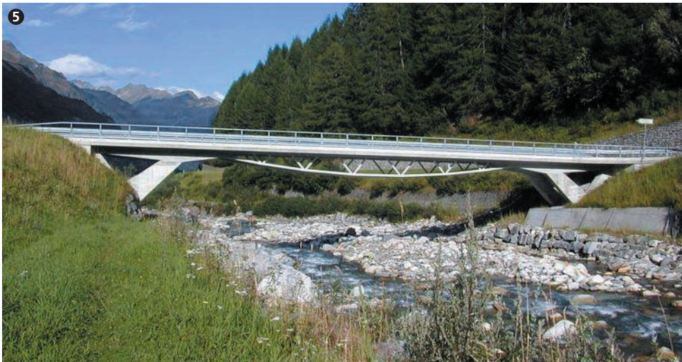
Pont sur le Tessin à Villa Bedretto. Ticino bridge in Villa Bedretto.
