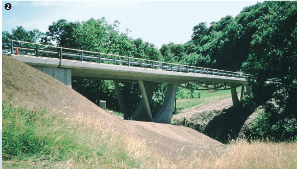
Pont sur la Capriasca à Odogno. Capriasca bridge in Odogno.
